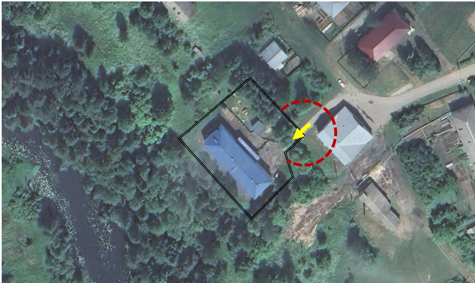
Большеустинский ФАП – с.Большое Устинское, ул.Набережная, д.3
